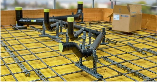
Bei der Planung eines Entwässerungssystems, bei dem die horizontal verlaufenden Verbindungsrohre in die Betondecke eingelassen sind, können Benutzer die neuen Geberit Einlegerohrschellen nun direkt in das Modul Schemaplanung integrieren.
